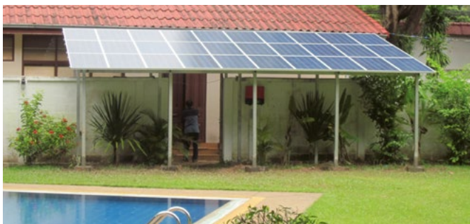
Stromversorgung bei Netzausfall
