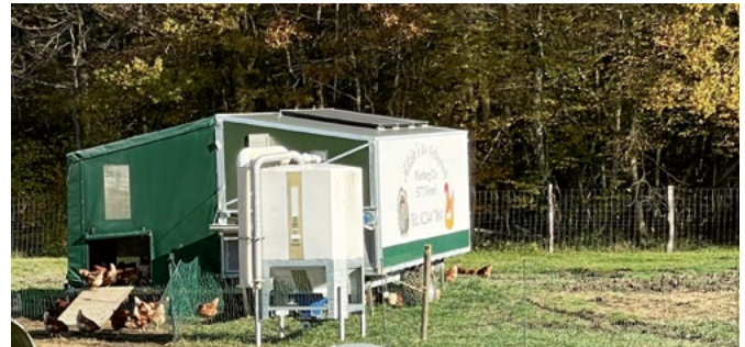
Stromversorgung eines mobilen Hühnerstalls
